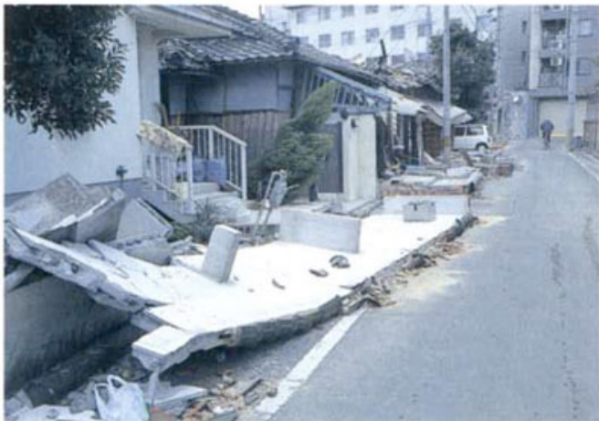
阪神・淡路大震災におけるブロック塀の倒壊（1995年）
