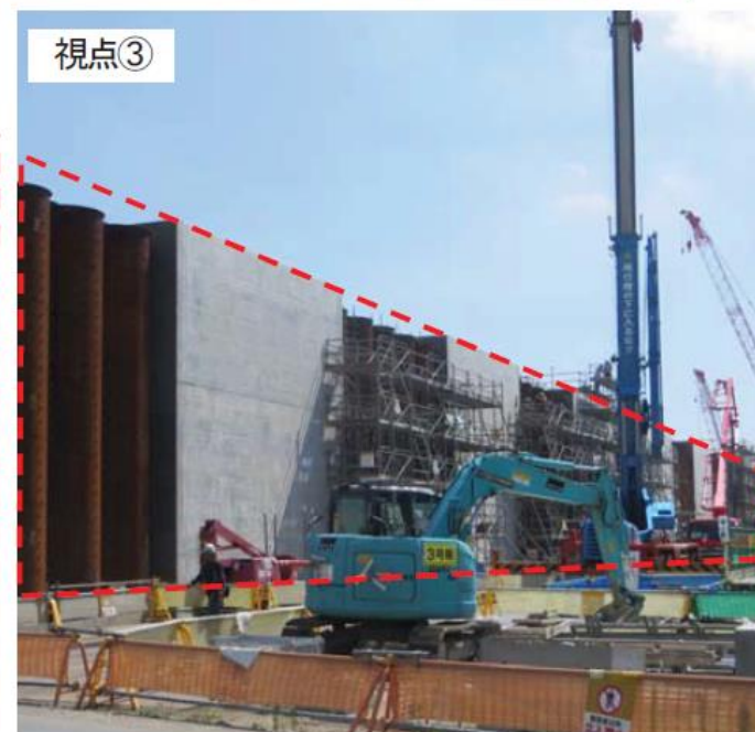
防潮堤(南・北側)の状況 赤枠: 鉄筋コンクリート施工箇所
