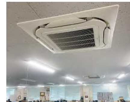
改修工事後のエアコンとLED照明（八王子センター）
