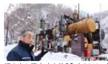
湧き出した温泉水を使う「バイナリー方式」 の地熱発電。温泉が枯渇する恐れ がないと注目される
