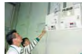
間欠制御装置 冷凍庫・冷蔵庫・空調に設置する。30分ごとに数%の時間、圧縮機を停止して節電を行う
