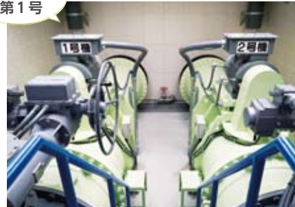
山形県の土地改良区で初の、本格的な小水力発電所「のがわデンデン」。プロペラ水車を組み込んだ2台の発電装置
