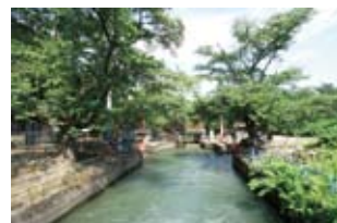
農業用水路にバイパスを設けて、発電所に水を引き込む
