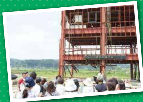
津波で被災した南三陸町防災対策庁舎 (宮城県)
